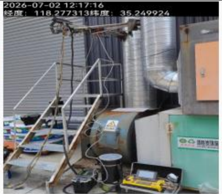
图6 2#车间西挤出工序出口
