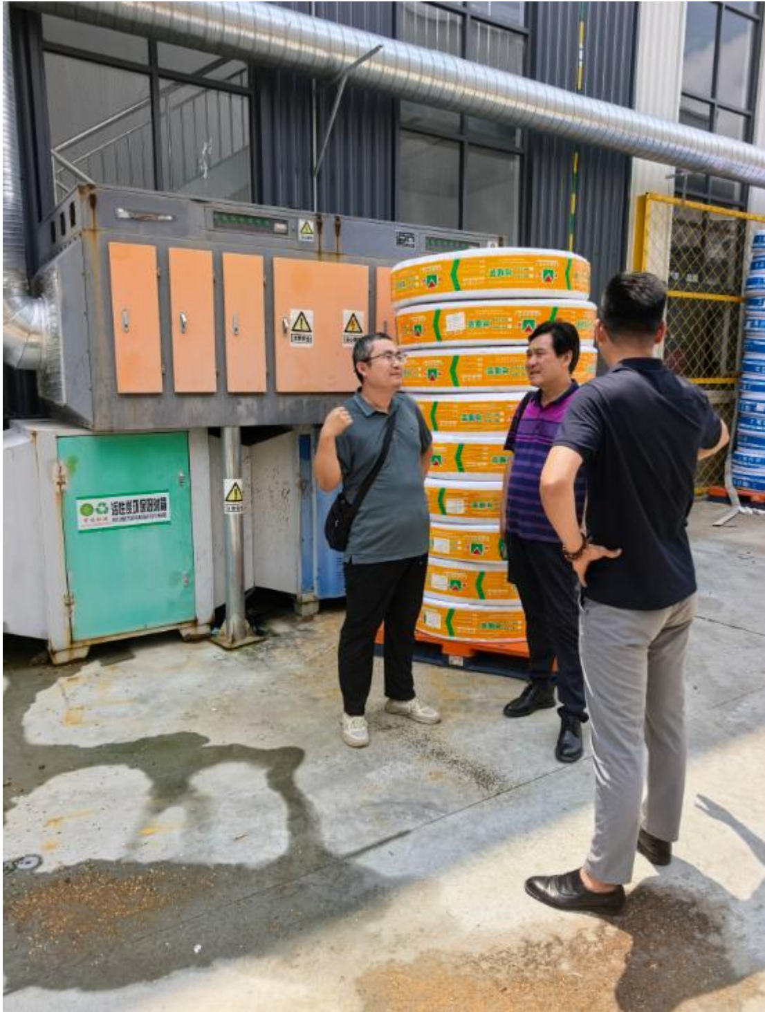
验收工作组踏勘项目现场照片
