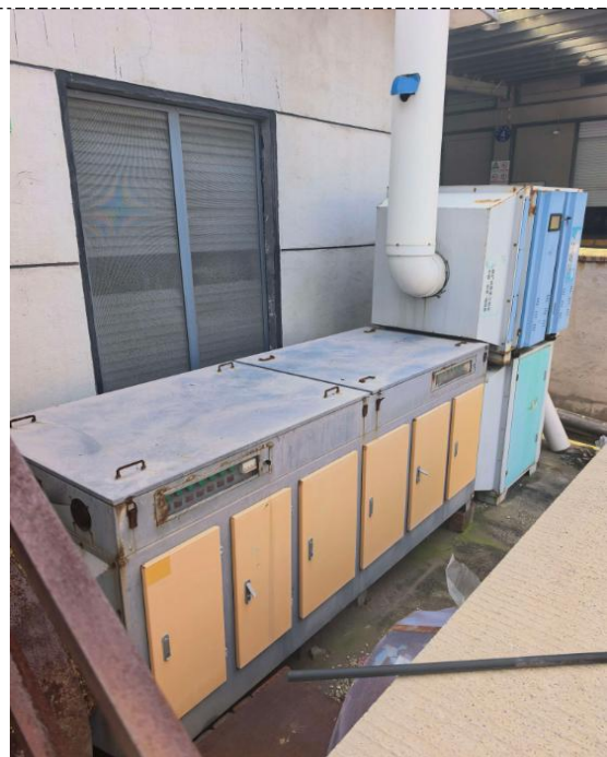
DA001 油烟净化器+活性炭吸附+光氧催化装置
