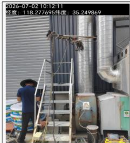
图 7 2#车间西挤出工序进口
