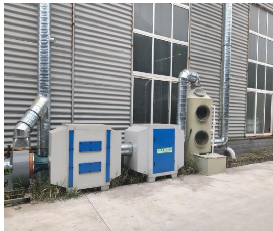
有机废气处理设备（只有二级活性炭） （喷淋塔仅作为烟道缓冲连接，未使用）
