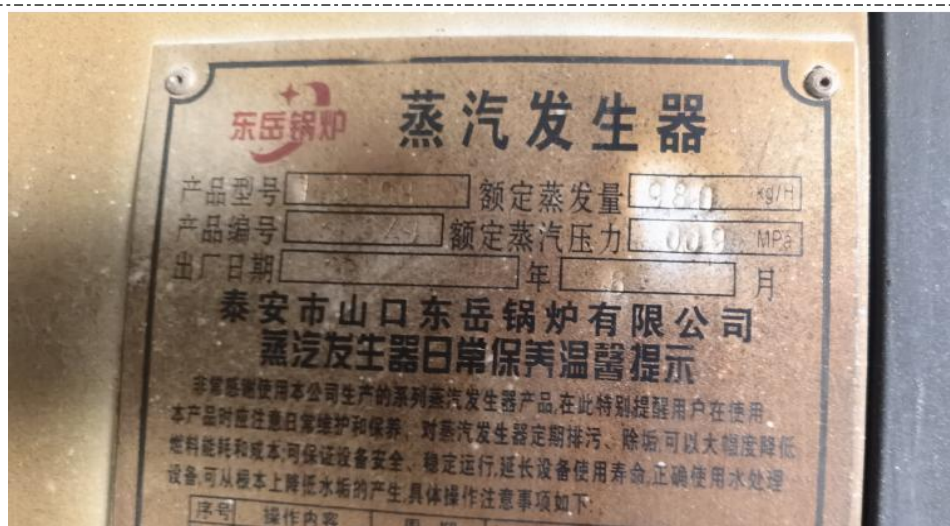
图 3-8 生物质蒸汽发生器铭牌
