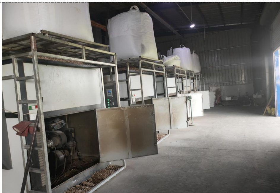
图 3-7 生物质蒸汽发生器
