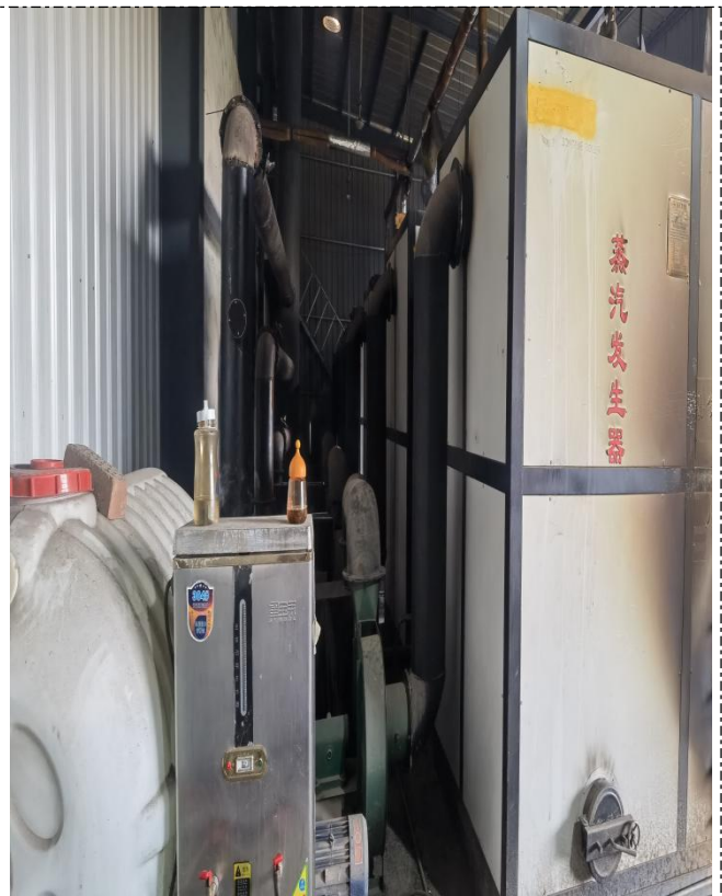
图 4-2 生物质蒸汽发生器燃烧废气排气筒现场照片（DA001）
