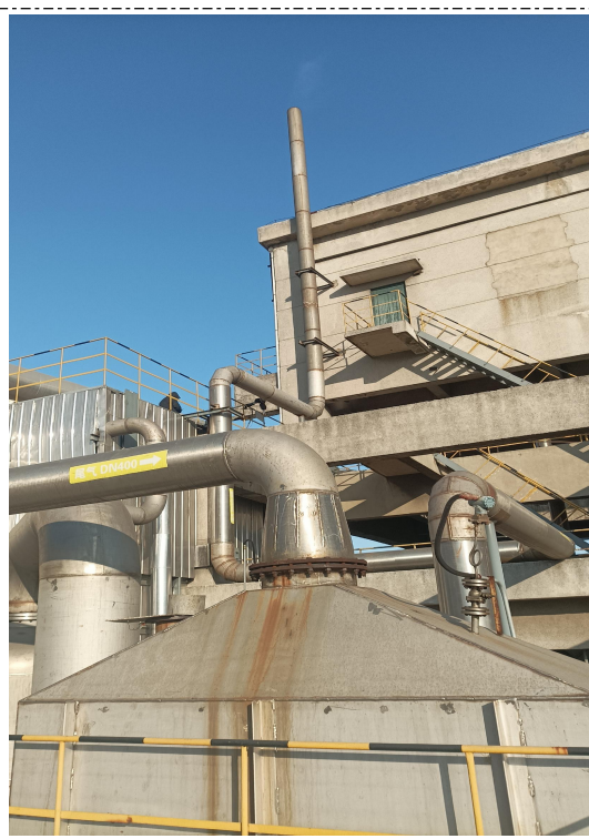
工艺废气排气筒
