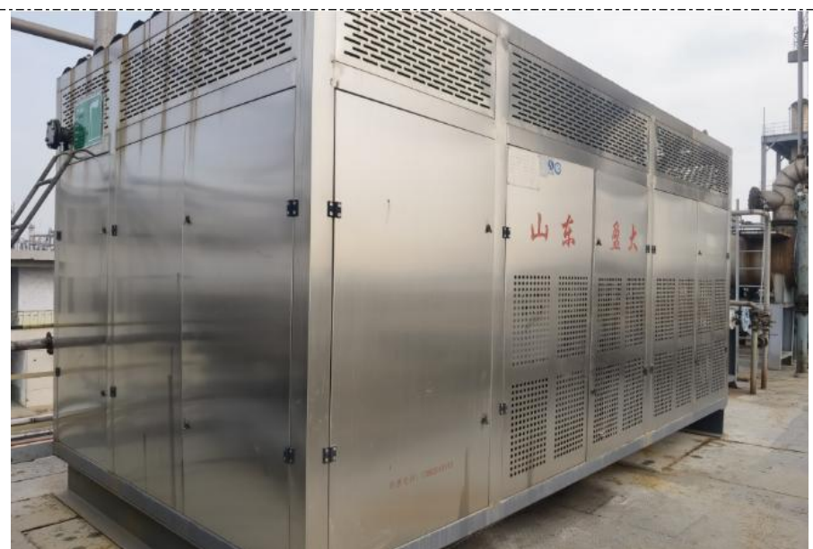
“两级冷凝（5℃）+活性炭吸附-脱附”装置
