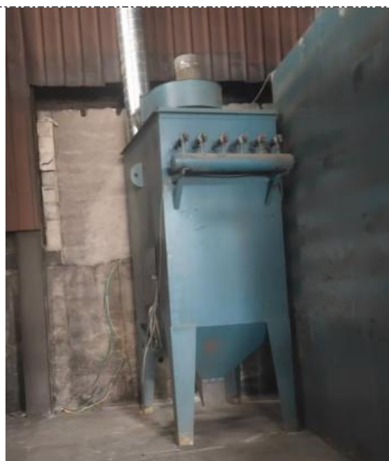
喷砂工序脉冲布袋除尘器
