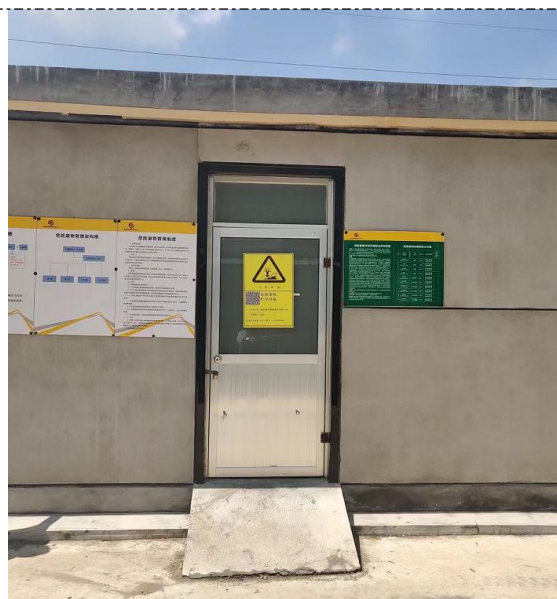
危险暂存间外部
