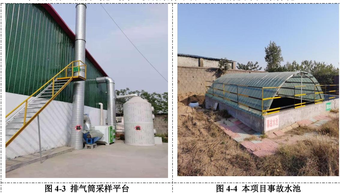
图 4-3 排气筒采样平台
