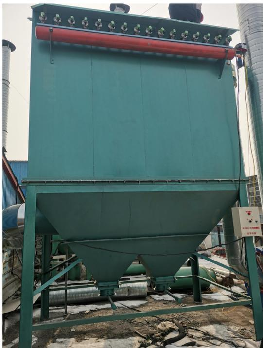
图 4-3 静电分离工序废气处理设施
