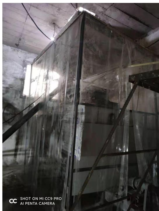
图 4-1 废气集气罩
