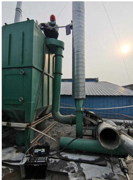
图 4-4 磨粉工序废气处理设施
