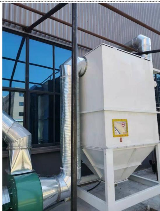
切割、焊接工序脉冲布袋除尘器
