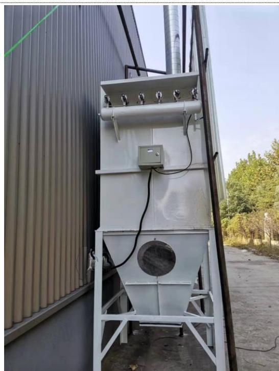
木工加工工序脉冲布袋除尘器
