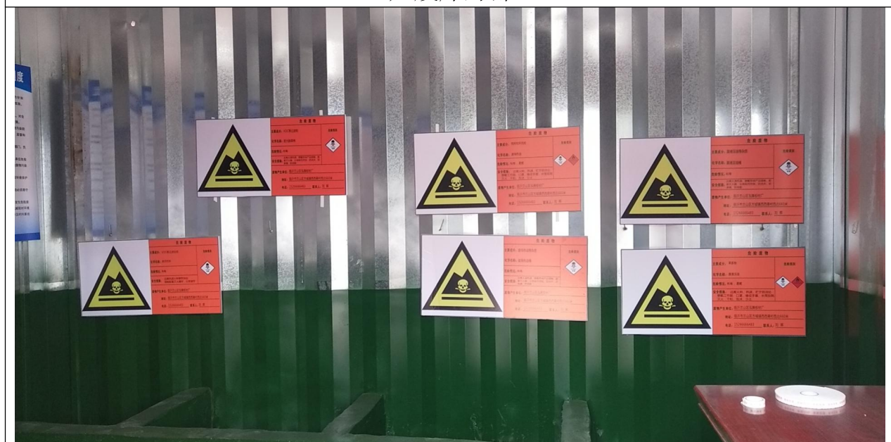
危废库内部分区及标识
