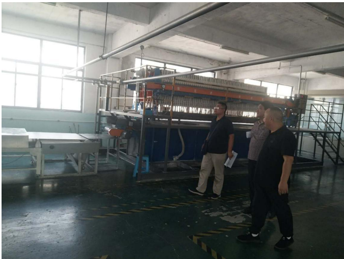
验收工作组踏勘项目现场
