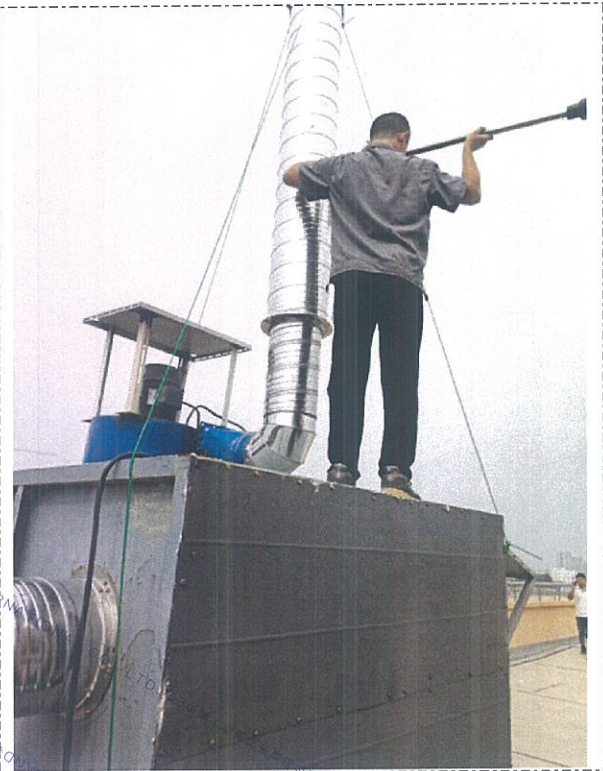
图 2: 焊接工序出口现场采样图
