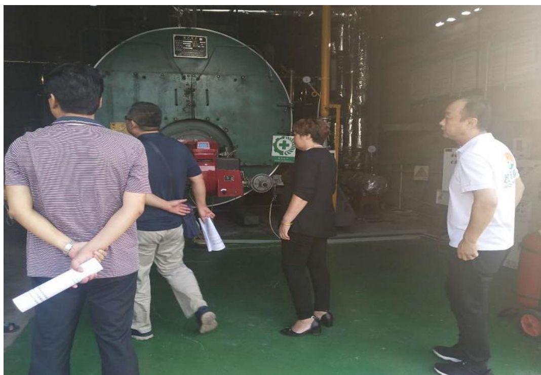
验收工作组踏勘项目现场
