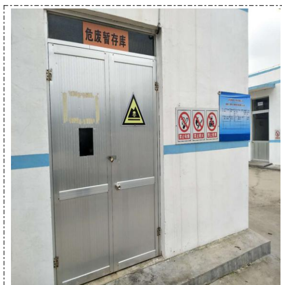
图 4-10 危险废物暂存库
