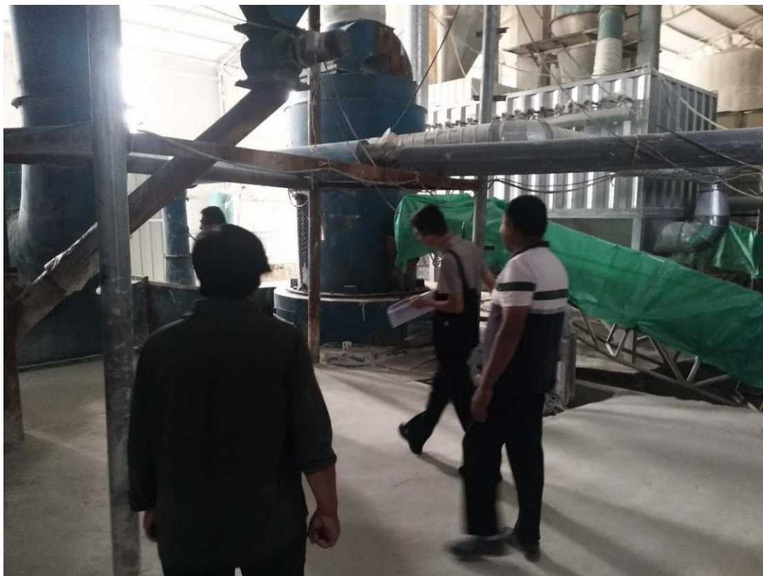
验收工作组踏勘项目现场
