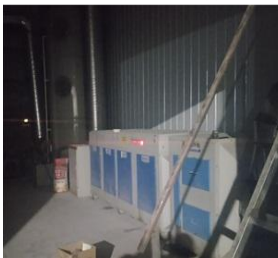
图 4-1 水喷淋+光催化氧化+活性炭吸附装置
