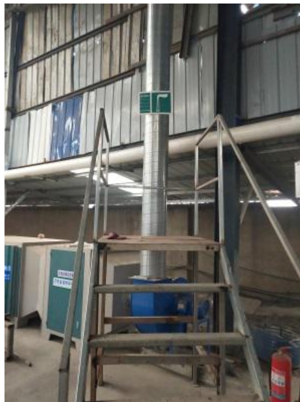
图 4-2 废气采样平台
