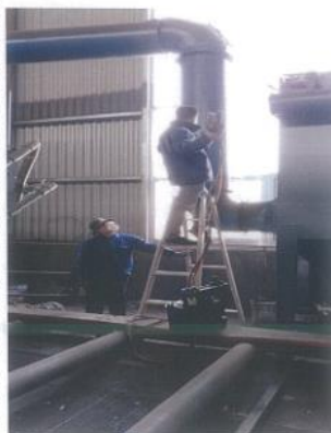
图 3 抛丸西侧工序进口现场采样
