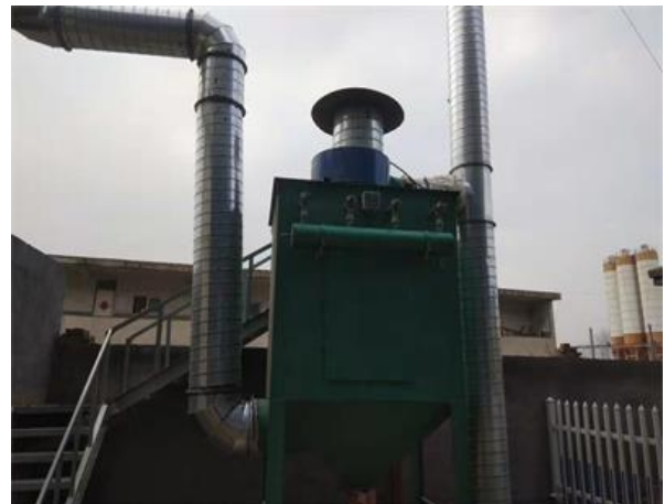
图 4-1 脉冲布袋除尘器
