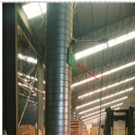
图 4-3 废气排放口标识牌
