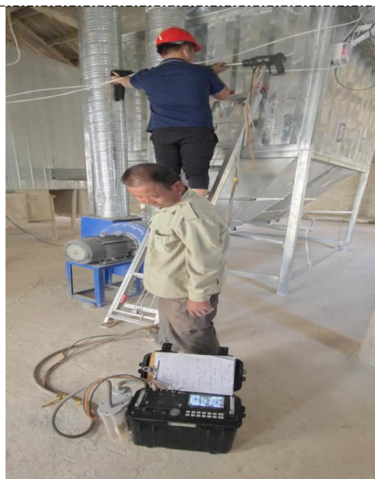
图 4-4 雷蒙磨废气检测口
