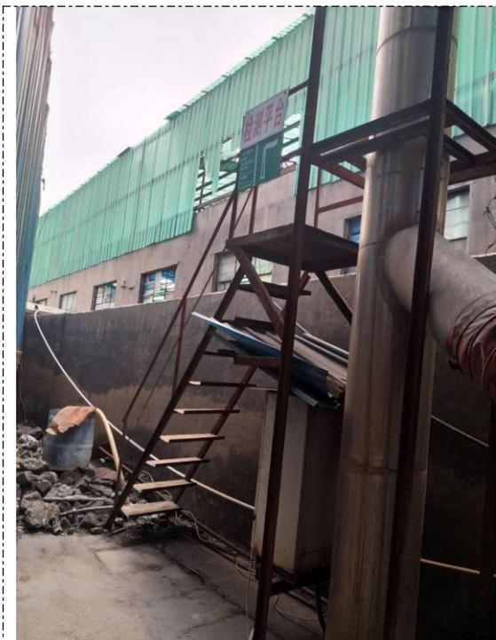
图 4-3 炒灰机排气筒检测平台
