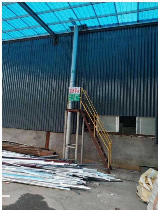
图 4-4 喷砂机排气筒检测平台
