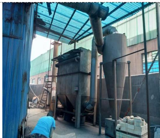
图 4-1 炒灰废气处理设施
