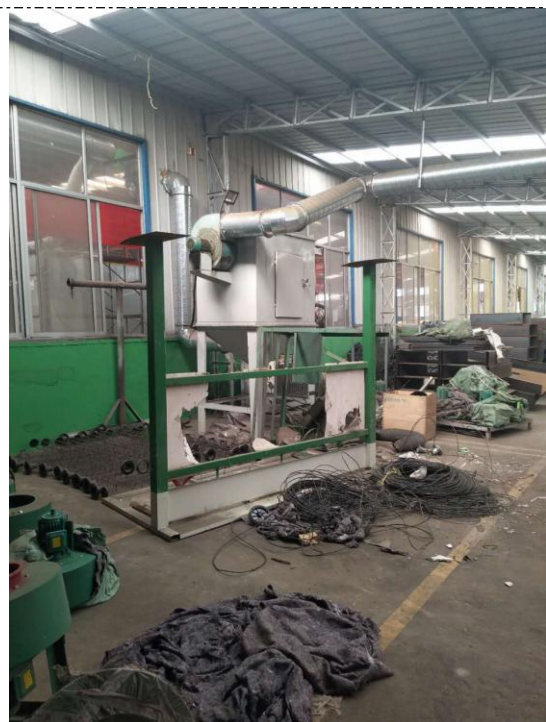
图 4-3 环焊机除尘器
