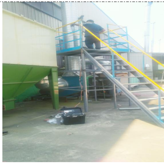
图 4-7 焊接、切割排气筒采样平台
