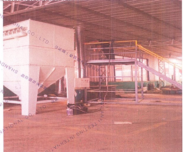
图4: 喷塑工序出口现场采样图
