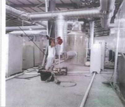
图 1: 1#熔融挤出工序进口采样图
