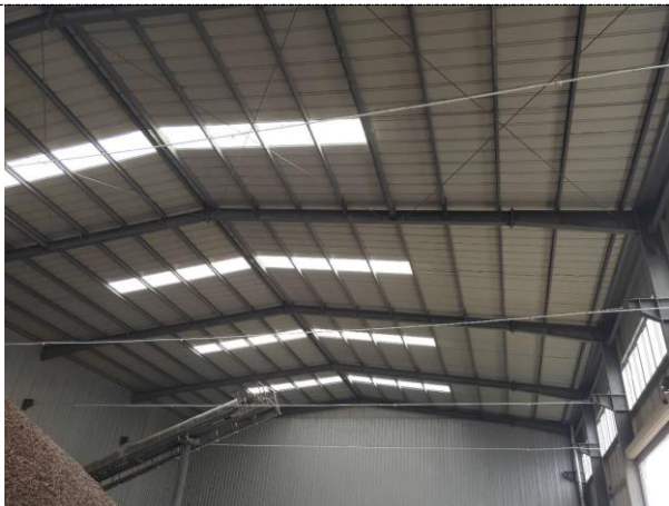
图 4 原料堆场水喷淋装置
