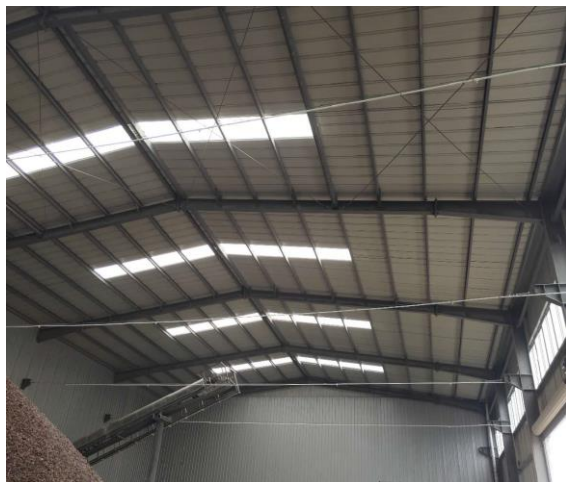
图 4-1 原料堆场水喷淋
