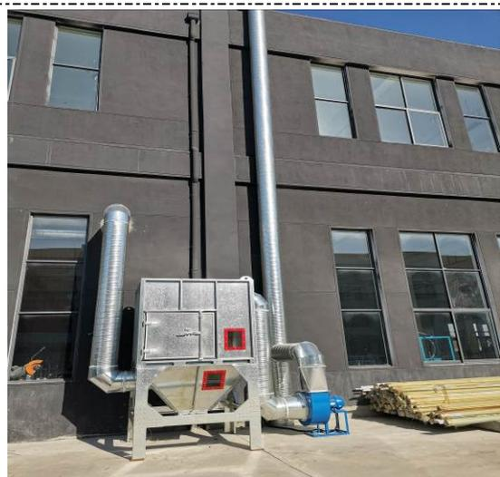
图 4-1 锯切工序、打磨工序布袋除尘器
