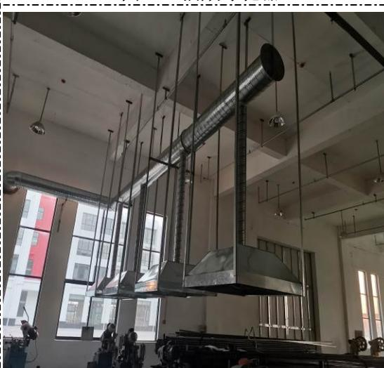
图 4-6 锯切工序集气罩
