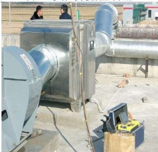
图 4-5 固化工序 UV 光氧催化器
