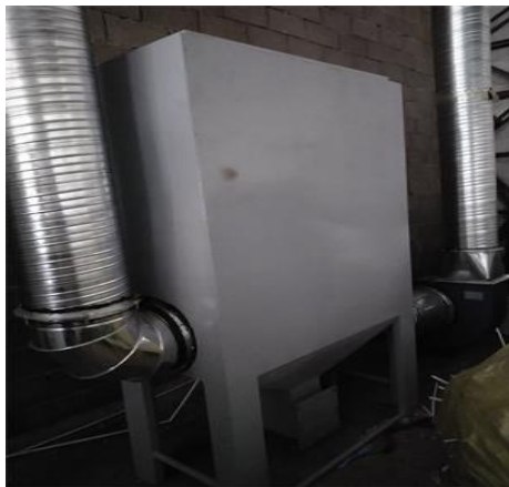
图 4-3 脉冲布袋除尘器设备
